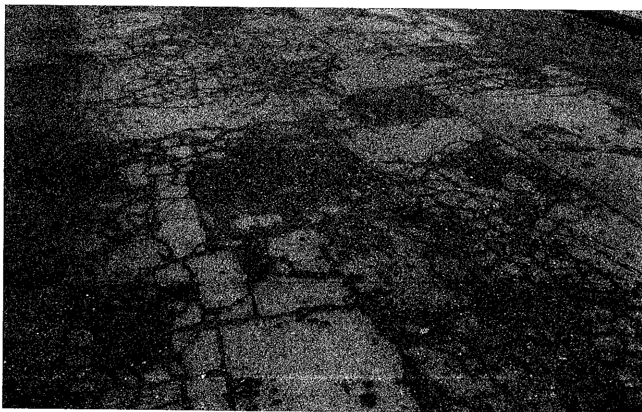
Fot. 2. Ulica Krótka, stan nawierzchni.
