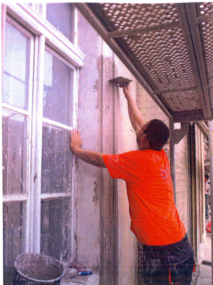
Fot. 15. Kętrzyn, Dworzec kolejowy, elewacja południowa, próba uzupełnienia profili opasek okiennych metodą ciągnioną za pomocą szablonu wykonanego z metalowej blachy.
