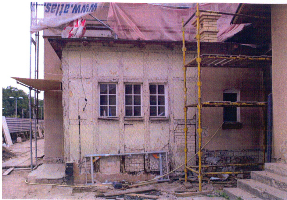
Fot. 9. Kętrzyn, Dworzec kolejowy, ściana ryglowa przybudówki wschodniej, widoczna konstrukcja ryglowa po odsłonięciu z wtórnych tynków. Okna są prawdopodobnie pierwotne, osadzono je w polach między belkami i ryglami.
