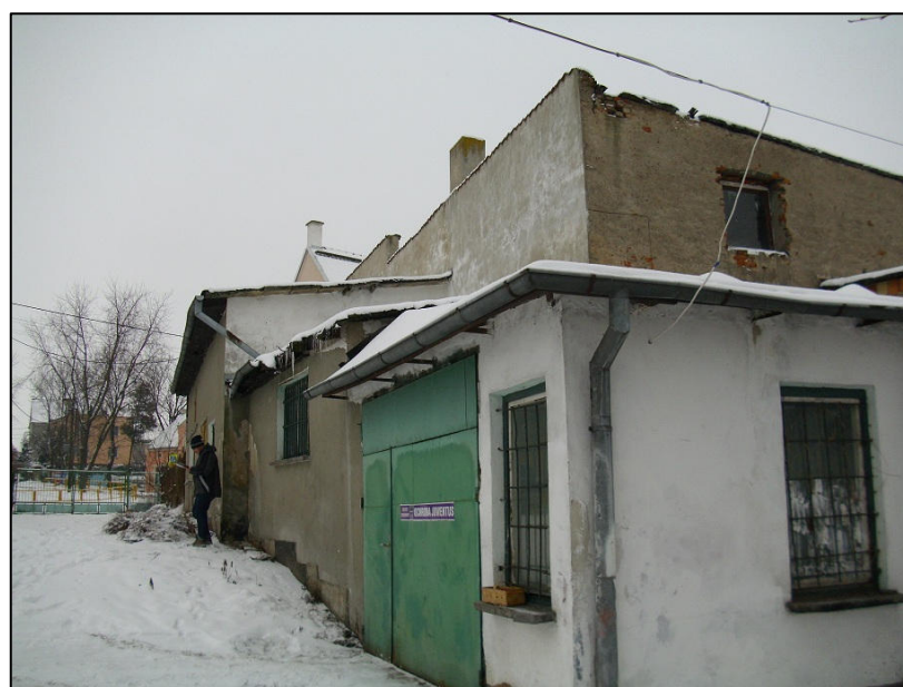
Fot. nr 3 „Widok ogólny bud. magazynowych – elewacja południowa”
