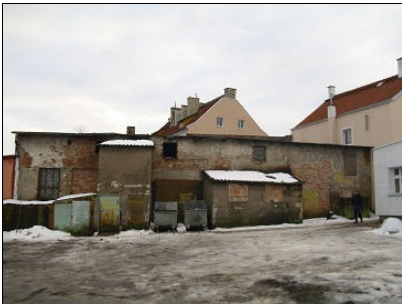
Fot. nr 1 „Widok ogólny bud. magazynowych – elewacja północna”
