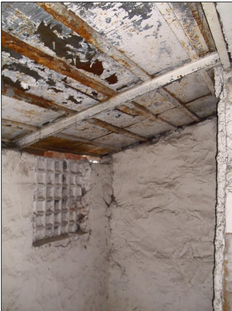
Fot. nr 5 „Widok wew. bud. magazynowych ”
