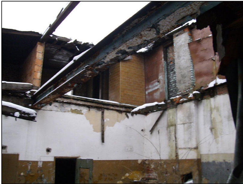
Fot. nr 4 „Widok wew. bud. magazynowych ”
