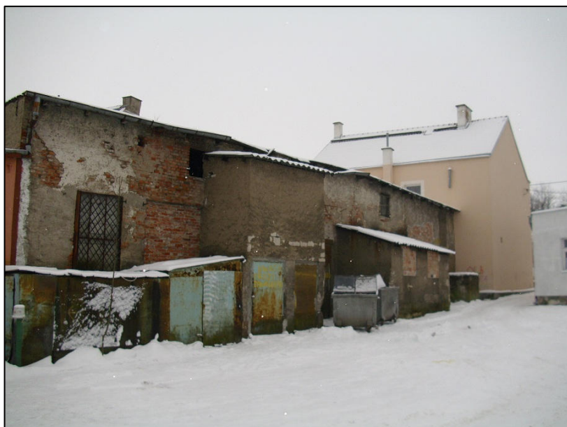
Fot. nr 2 „Widok ogólny bud. magazynowych – elewacja północna”
