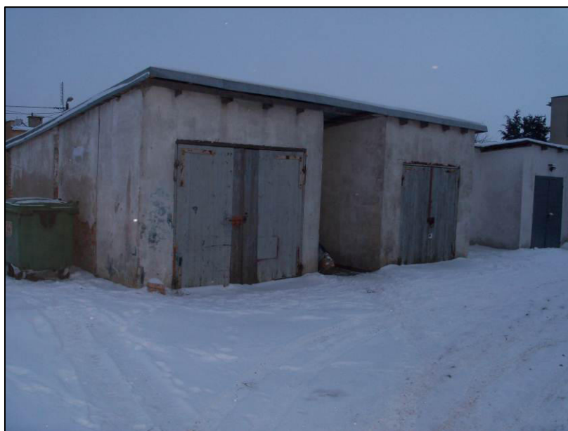
Fot. nr 3 „Widok ogólny budynków garażowych – elewacja frontowa”
