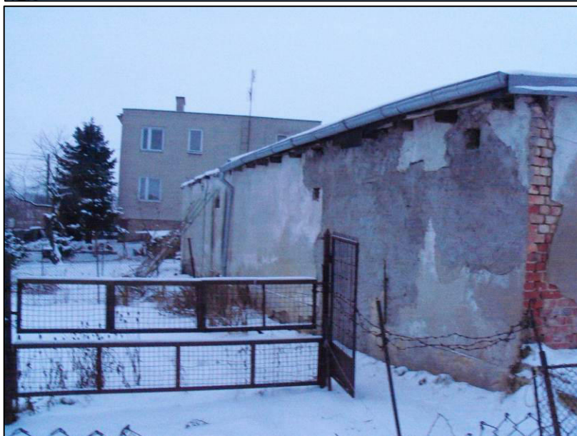
Fot. nr 2 „Widok ogólny budynków garażowych – elewacja tylna”
