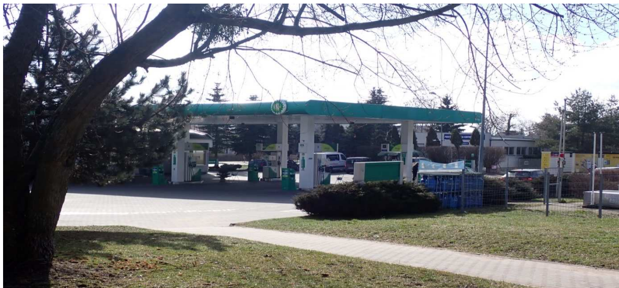
Zdjęcie 1. Istniejąca zabudowa usługowa – stacja paliw (dz. nr 180)
