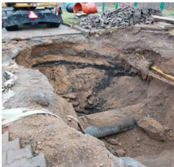
Widok by-passu kolektora deszczowego
