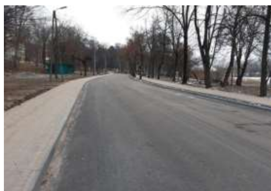
Ul. Kajki- – zdjęcia po realizacji
