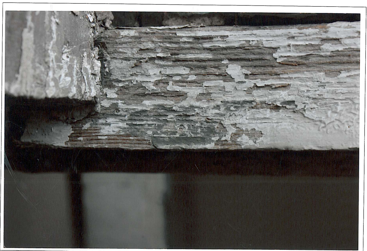
W odkrywcze widoczna śladowo zachowana, szara kolorystyka stolarki okiennej
