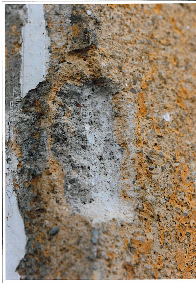
Dworzec kolejowy w Kętrzynie–przybudówka północna, wejście główne, gzyms podokienny. W odkrywcę widoczny tynk barwiony w masie
