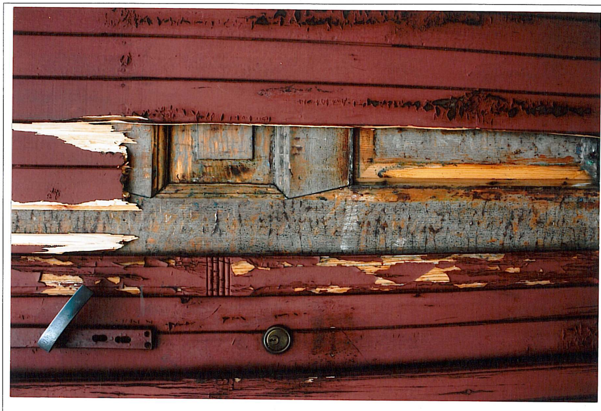
Dworzec kolejowy w Kętrzynie; przybudówka wschodnia, ściana południowa – podwójne drzwi wejściowe o konstrukcji ramowo-płycinowej
