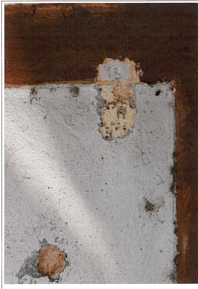
Dworzec kolejowy w Kętrzynie – przybudówka północna, wejście główne, zadaszenie nad schodami wejściowymi Widoczna warstwa tynku barwionego w masie na kolor ugrowy
