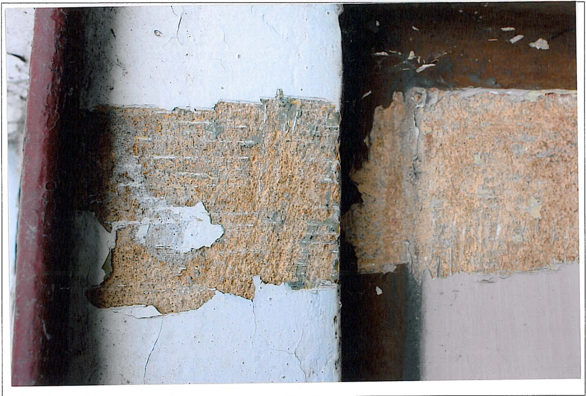
Dworzec kolejowy w Kętrzynie–przybudówka północna, wejście główne, gzyms podokienny. W odkrywcę widoczny tynk barwiony w masie
