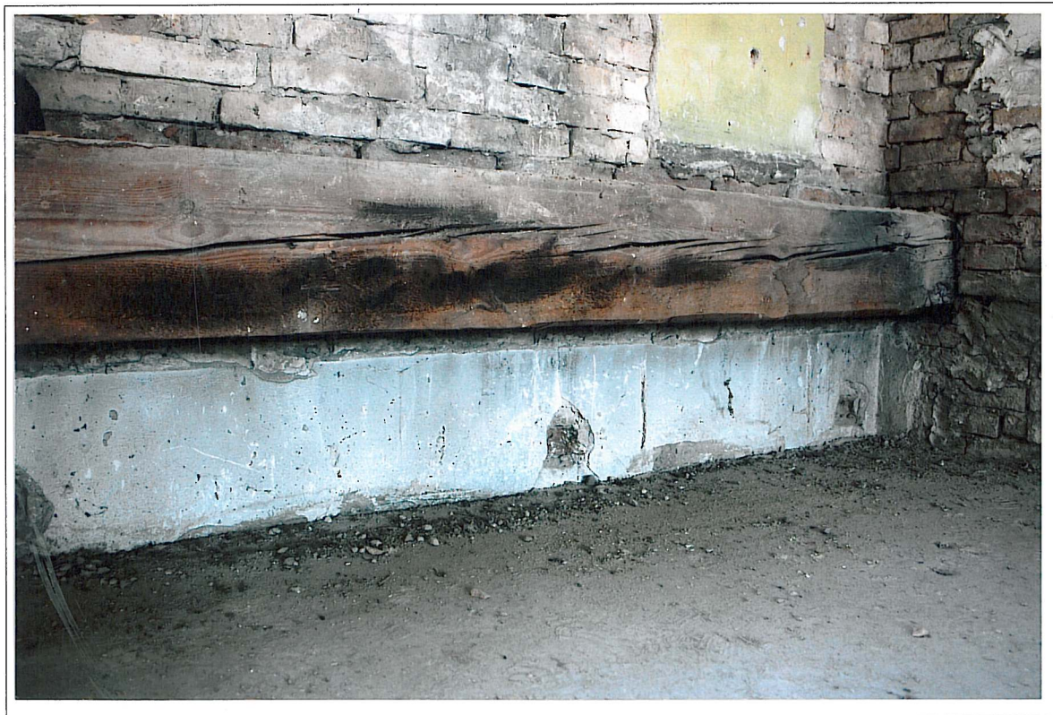
Dworzec kolejowy w Kętrzynie – pomieszczenie nad holem głównym. Widoczny pierwotny poziom stropów drewnianych i fragment ściany dawnego holu z warstwami pobiał.
