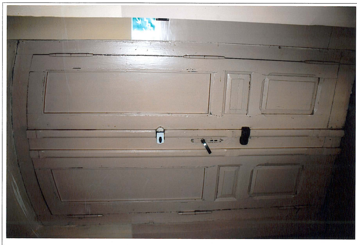
Dworzec kolejowy w Kętrzynie; przybudówka wschodnia, ściana południowa – podwójne drzwi wejściowe o konstrukcji ramowo-płycinowej
