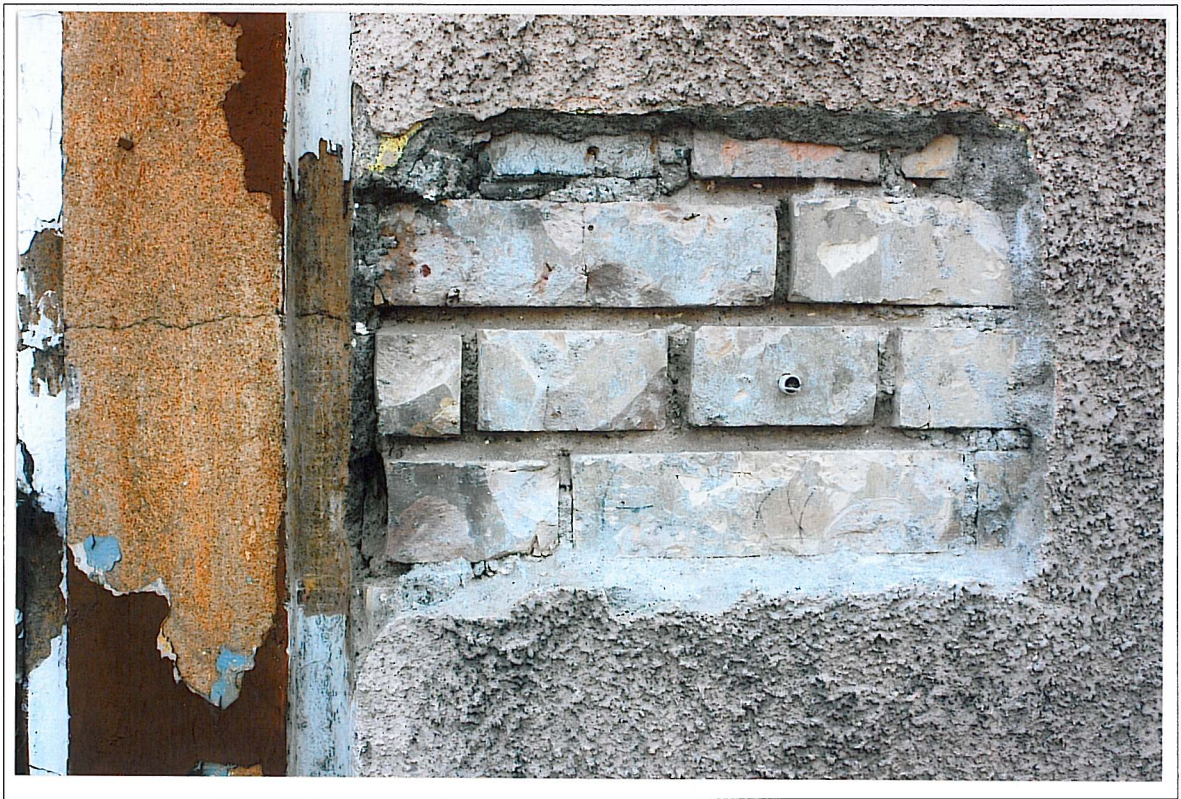
Dworzec kolejowy w Kętrzynie–przybudówka północna, wejście główne, W odkrywce widoczny tynk wążek ceglany z żółtawej licówki oraz niewielki fragment zachowanej fugi
