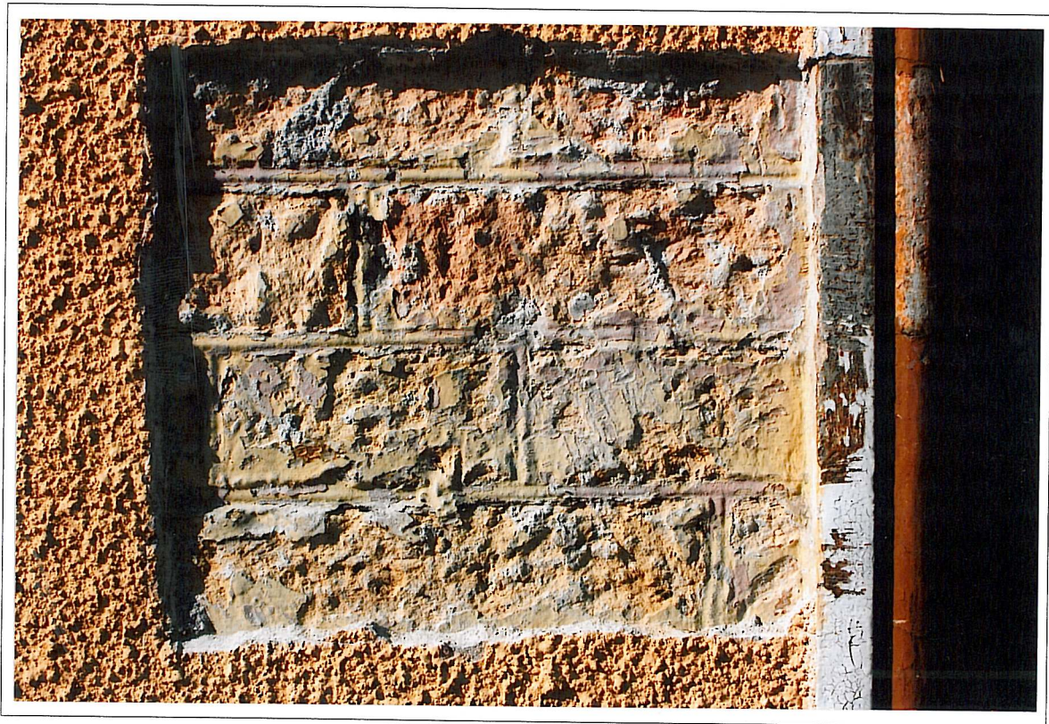
Dworzec kolejowy w Kętrzynie – ściana wschodnia ryzalitu wschodniego, poziom I piętra. W odkrywcę widoczny wątek ceglany
