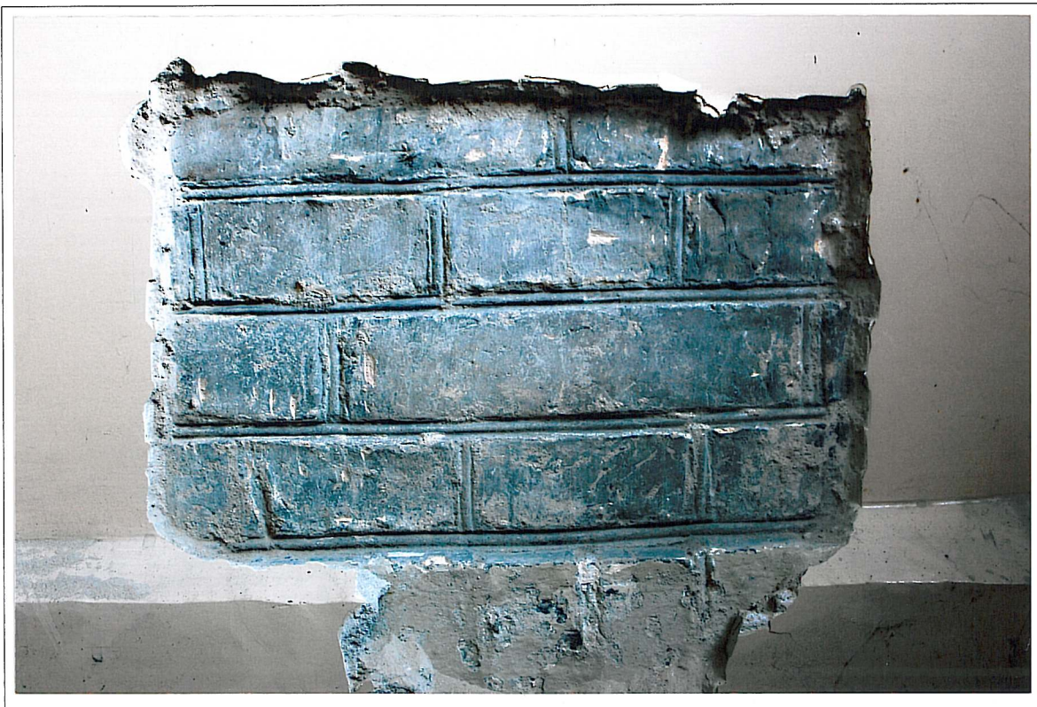
Dworzec kolejowy w Kętrzynie – ściana zachodnia ryzalitu wschodniego; widoczne dobrze zachowane, pierwotne opracowanie elewacji
