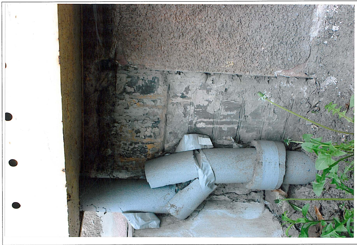
Ryzalit wschodni, strona północna; widoczny nieotynkowany cokół
