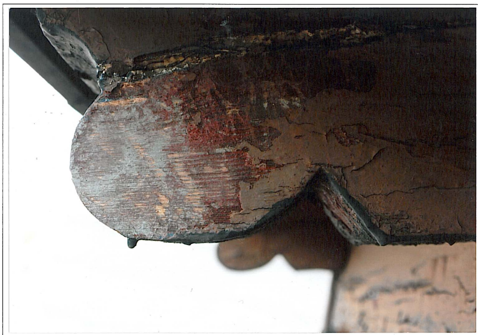
Dworzec kolejowy w Kętrzynie, elewacja północna; widoczne ozdobne opracowanie krokwi. Kolorystyka zbliżona do stolarki
