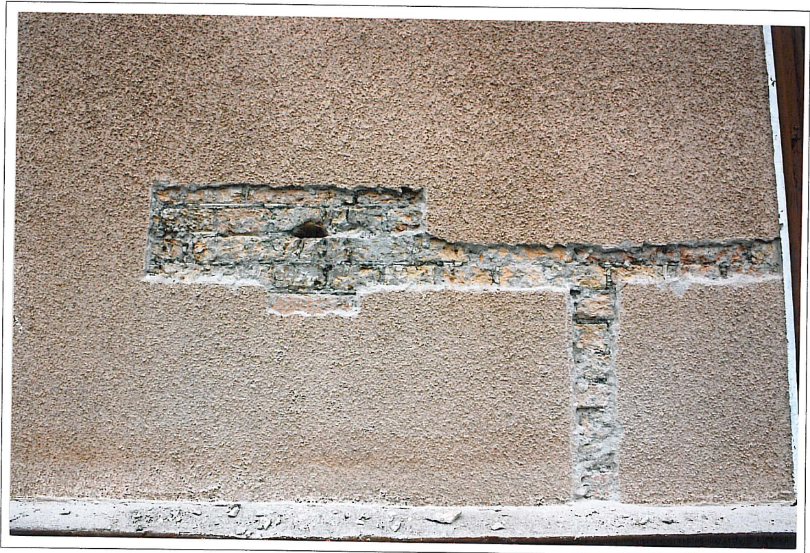
Dworzec kolejowy w Kętrzynie – ściana wschodnia ryzalitu wschodniego, poziom I piętra. W odkrywcę widoczny wątek ceglany
