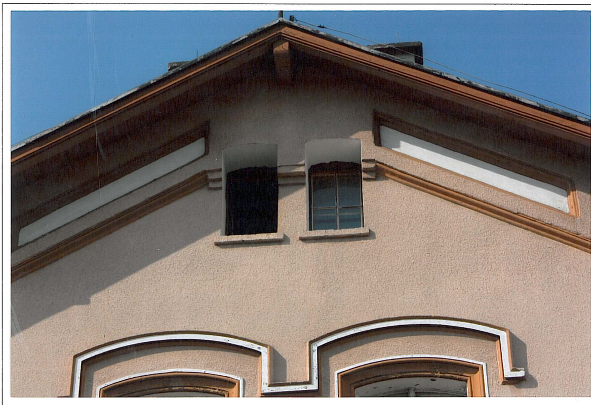
Dworzec kolejowy w Kętrzynie, ryzalit zachodni, elewacja południowa; wtórne otwory w układzie biforyjnym (po roku 1917). Stolarka współczesna
