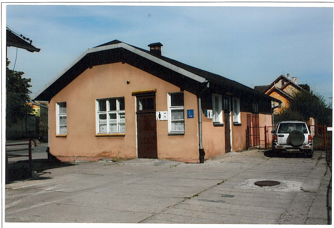
Dworzec kolejowy w Kętrzyni; ebudynek gospodarczy, elewacja zachodnia – nowe otwory okienne i drzwiowe z betonowymi nadprożami
