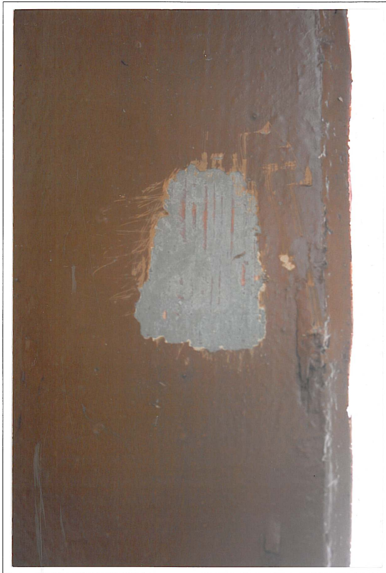
Dworzec kolejowy w Kętrzynie; przybudówka wschodnia – w odkrywce widoczna kolorystyka stolarki drzwiowej NCS – S 3005-B80G
