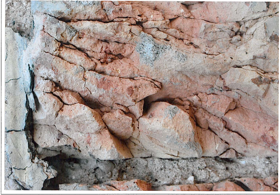
Cokół przybudówki wschodniej od strony południowej; stan zachowania cegieł
