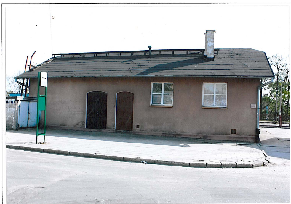
Dworzec kolejowy w Kętrzynie, budynek gospodarczy, elewacja północna
