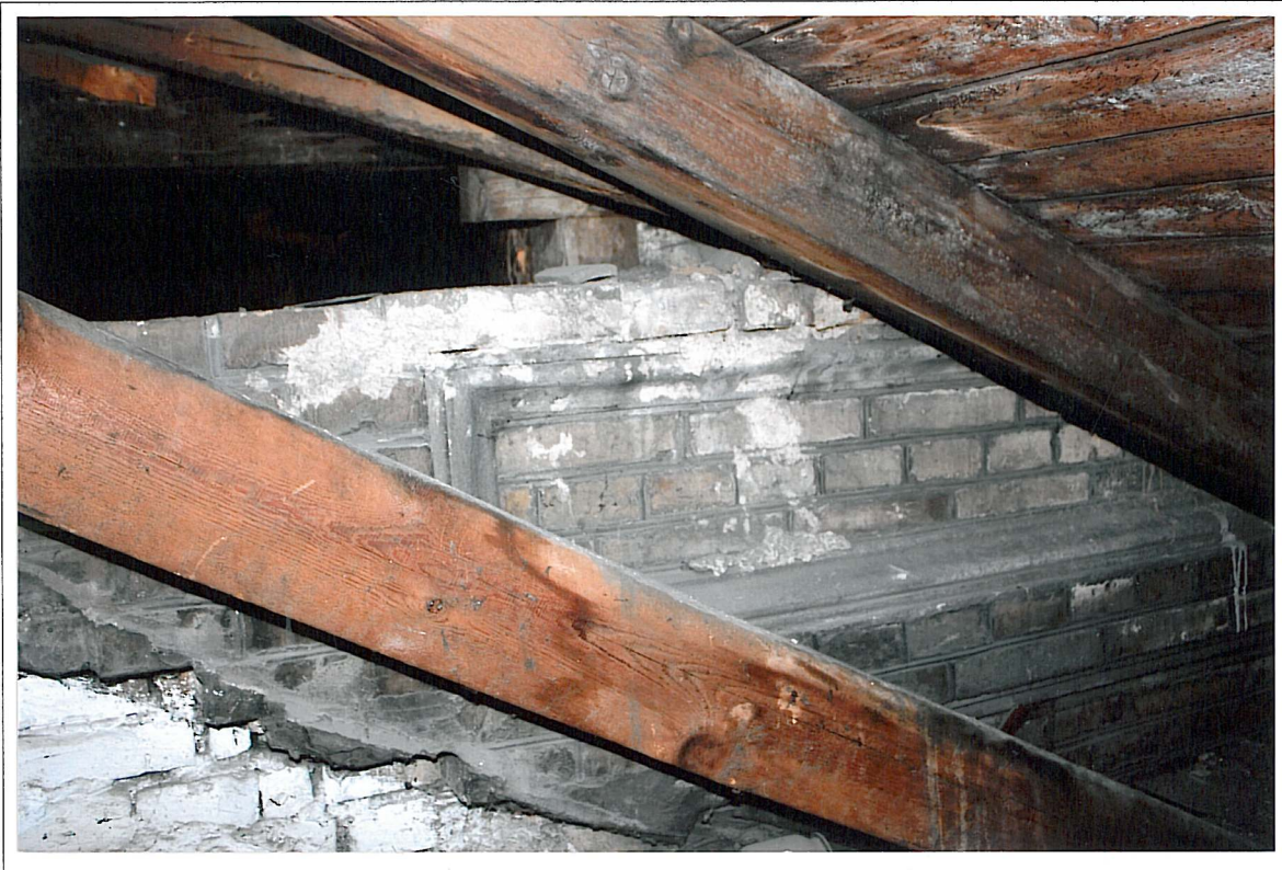
Dworzec kolejowy w Kętrzynie – ściana zachodnia ryzalitu wschodniego; widoczne dobrze zachowane, pierwotne opracowanie elewacji
