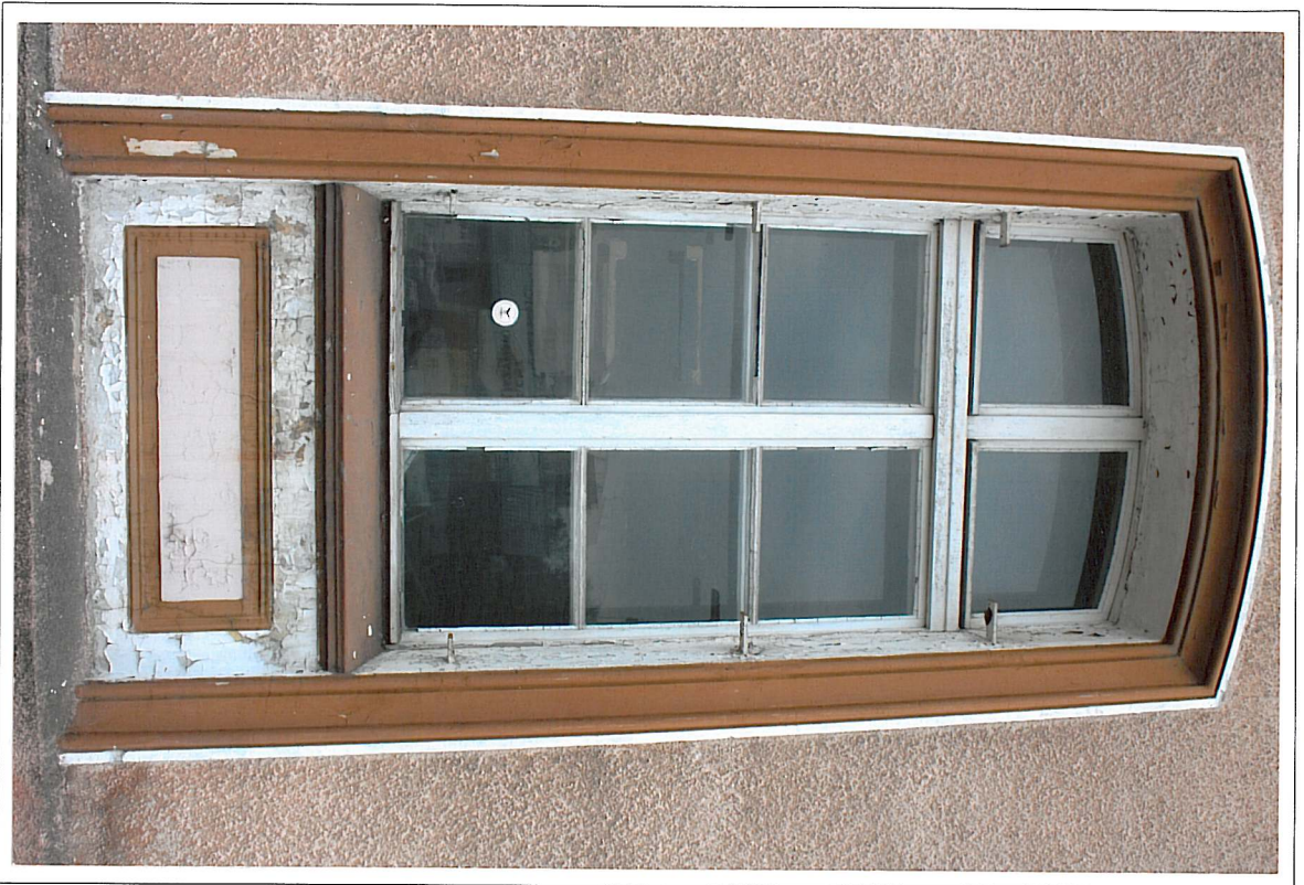
Część centralna bryły pierwotnej, elewacja północna; okno z okresu przebudowy.
