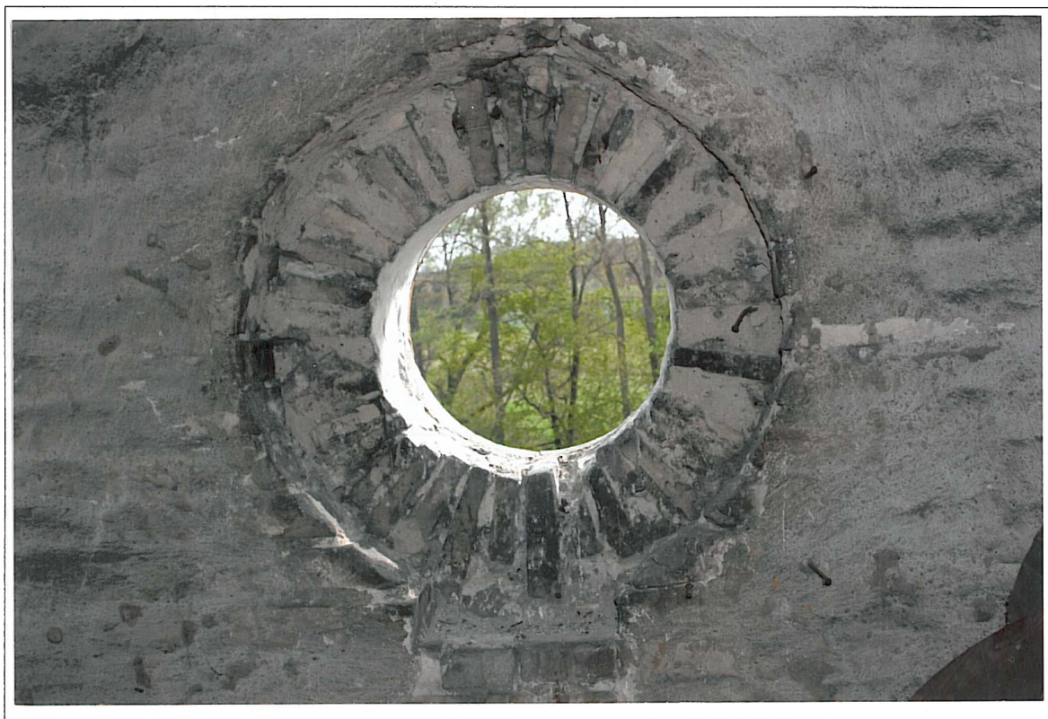
Dworzec kolejowy w Kętrzynie, ryzalit wschodni, ściana południowa; otwory w formie lunety pełnią funkcję wentylacji poddasza
