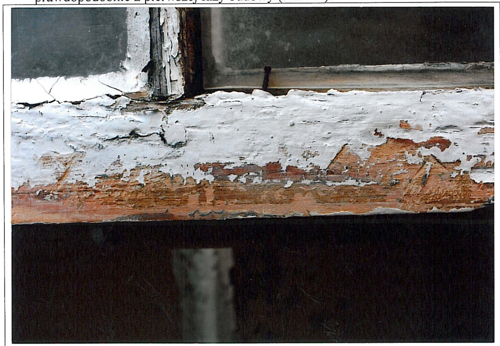
Dworzec kolejowy w Kętrzynie, ryzalit wschodni, elewacja północna; widoczny śladowo zachowany mazerunek
