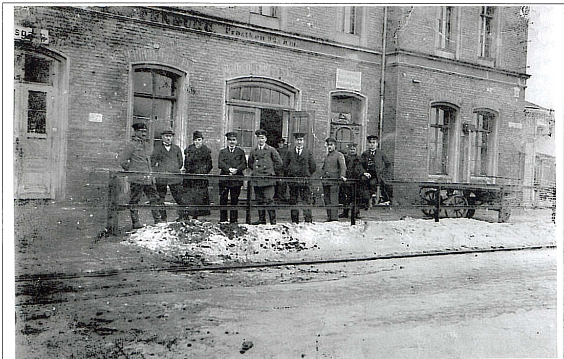
Dworzec kolejowy w Kętrzynie – fotografia datowana na rok 1920. Widoczne zmiany w otworach w poziomie parteru. Wątek ceglany w powiększonych otworach nawiązuje do pozostałych partii elewacji (źródło: Bildarchiv - Ostpreussen)
