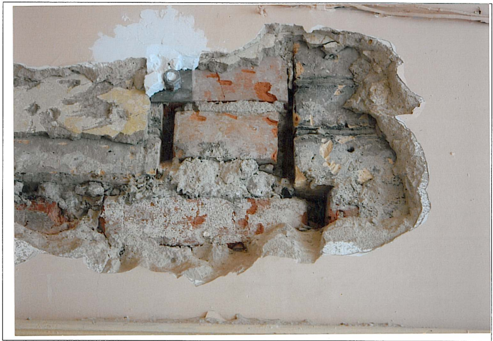
Dworzec kolejowy w Kętrzynie – ściana zachodnia zachodniego ryzalitu. Widoczna zamurowana nisza pierwotnie skrywająca rurę spustową
