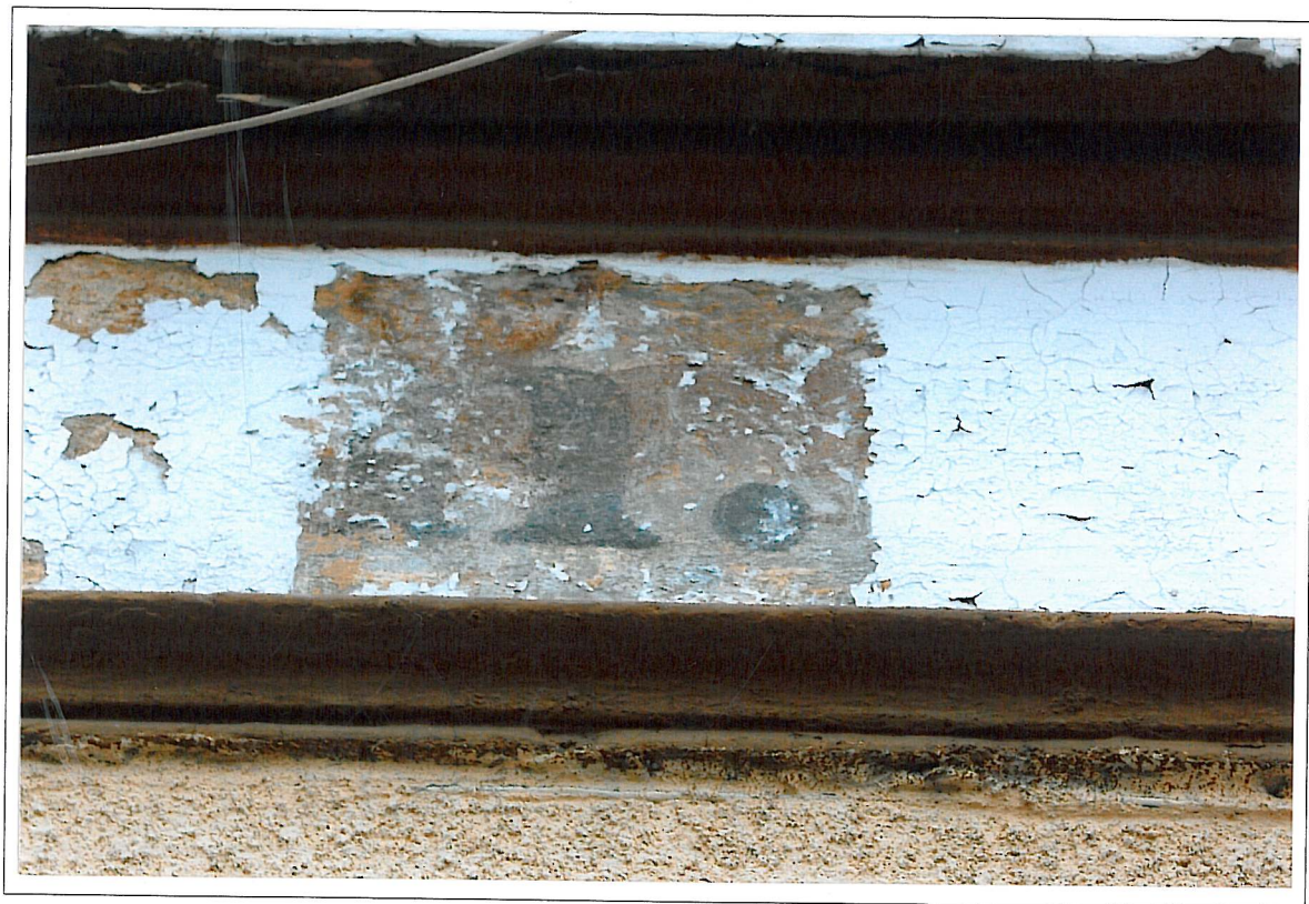
Dworzec kolejowy w Kętrzynie – ściana zachodnia ryzalitu zachodniego. Widoczny przekrój profilu. Profile ciągnięte bezpośrednio na elewacji na przekutych ceglach.
