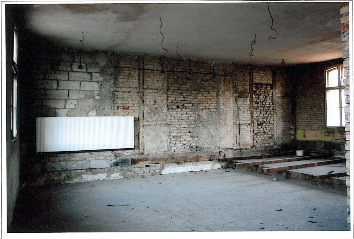
Dworzec kolejowy w Kętrzynie – pomieszczenie nad holem głównym. Widoczna konstrukcja szkieletowa ściany i liczne przemurowania
