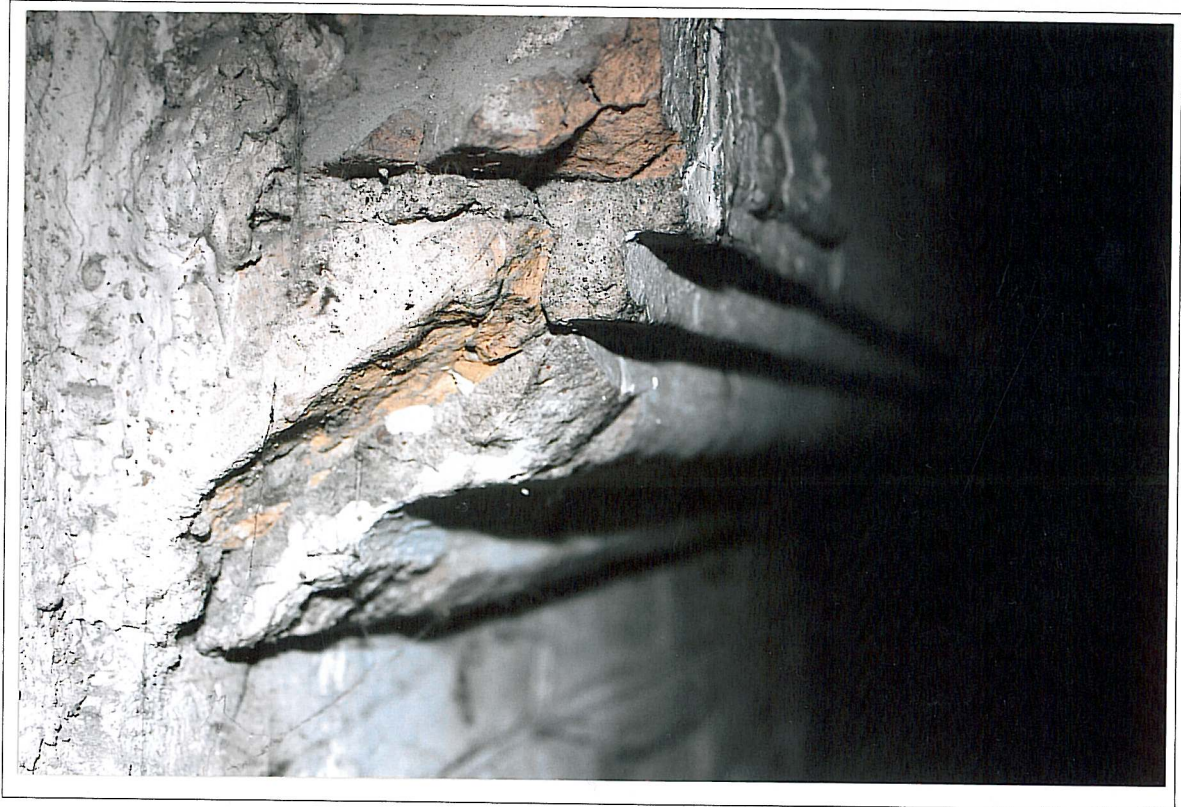
Dworzec kolejowy w Kętrzynie – ściana zachodnia ryzalitu zachodniego. Widoczny przekrój profilu. Profile ciągnięte bezpośrednio na elewacji na przekutych ceglach.
