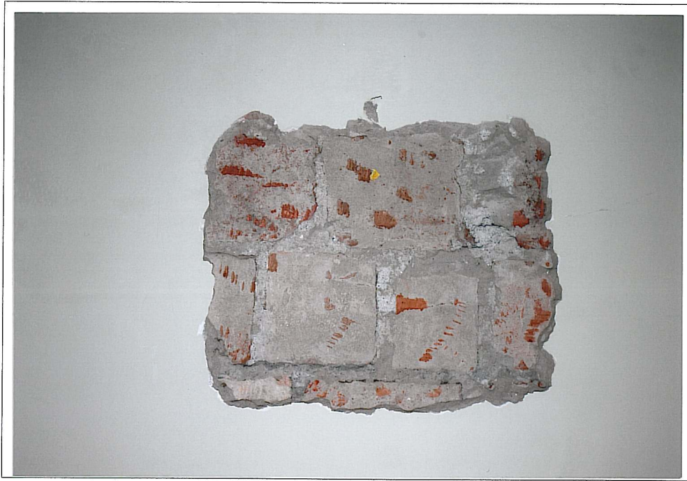
Dworzec kolejowy w Kętrzynie – wtórna ścianka działowa w bryle centralnej I piętro
