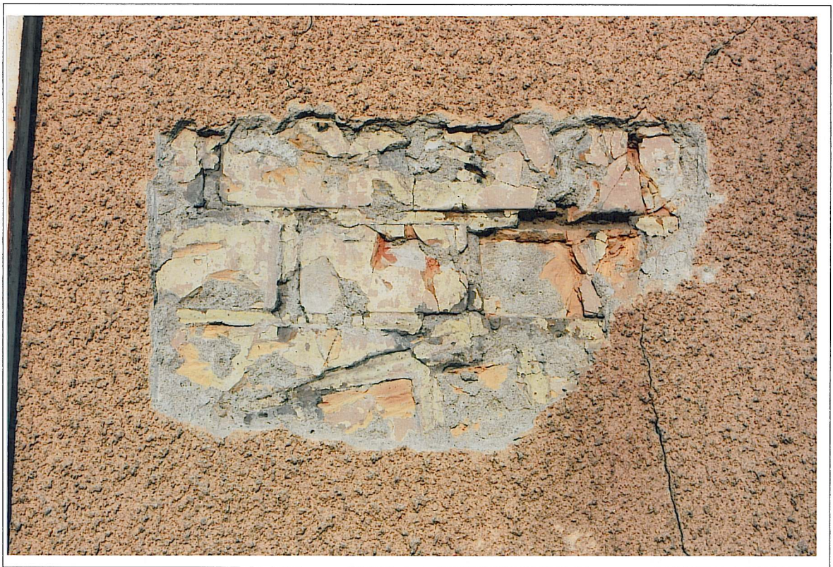
Dworzec kolejowy w Kętrzynie – ściana zachodnia dobudówka, poziom I piętra nad oknem. Widoczny stan zachowania cegły licowej po nasiekaniu.
