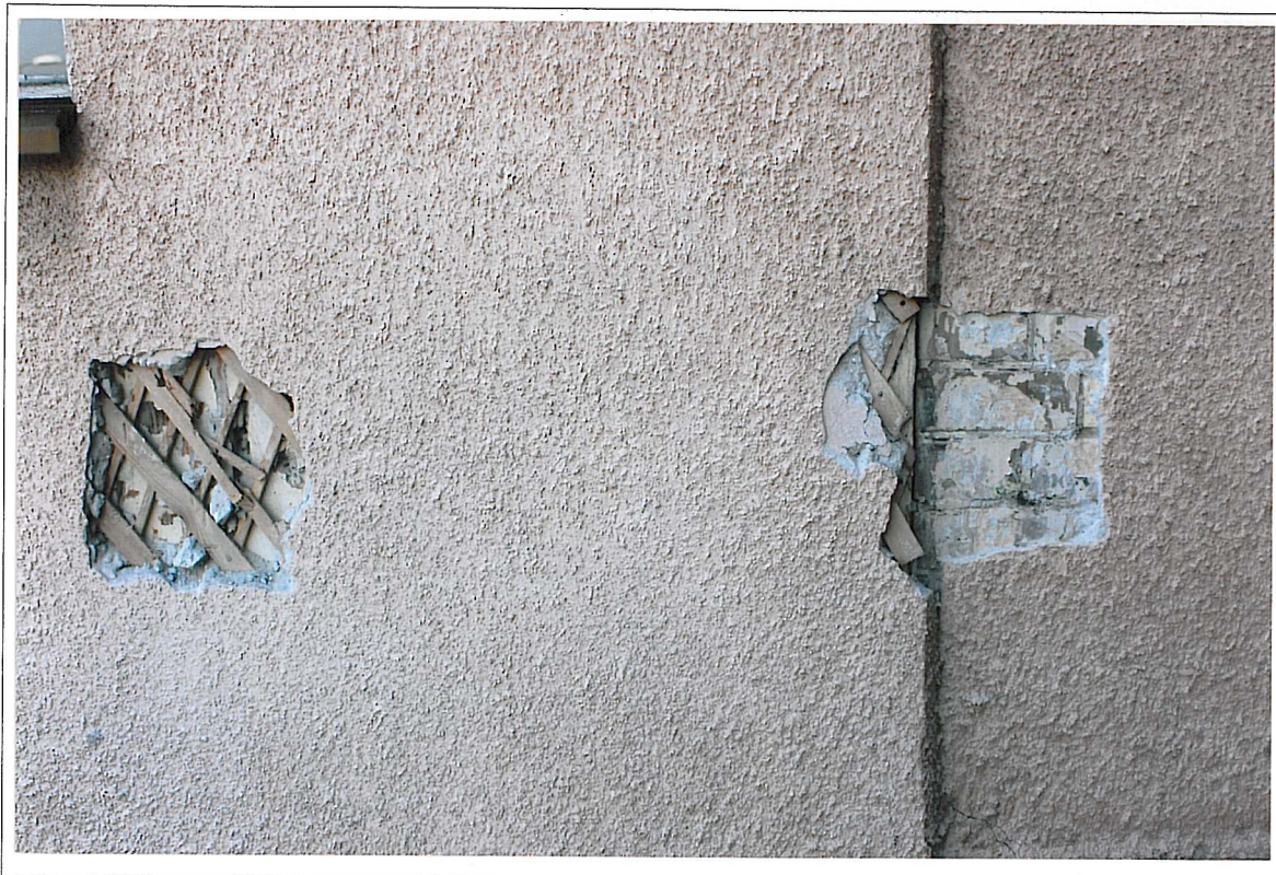
Dworzec kolejowy w Kętrzynie—drewniana konstrukcja małej przybudówki od strony wschodniej.
