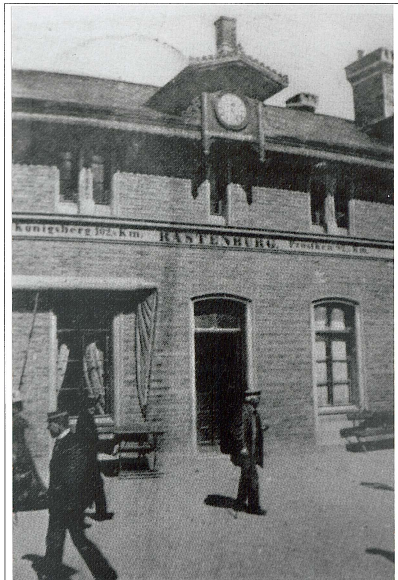
Dworzec kolejowy w Kętrzynie – stan przed podniesieniem poziomu dachu. Widoczna nie zachowana wieżyczka z zegarem. Po prawej ozdobne zwieńczenie kominów. Napis: „Koningsberg 102 Km. RASTENBURG. Prostken ..Km” zachowany pod przemalowaniami do dnia dzisiejszego (źródło: Bildarchiv - Ostpreussen)
