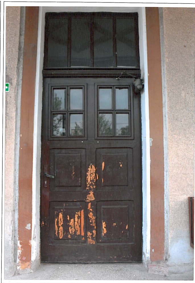
Dworzec kolejowy w Kętrzynie; przybudówka północna, wejście główne – wtórne skrzydła drzwiowe, strona wewnętrzna i zewnętrzna
