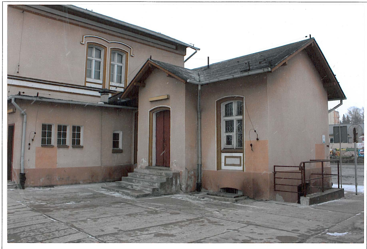
Dworzec kolejowy w Kętrzynie – elewacja i rozbudowa od strony wschodniej
