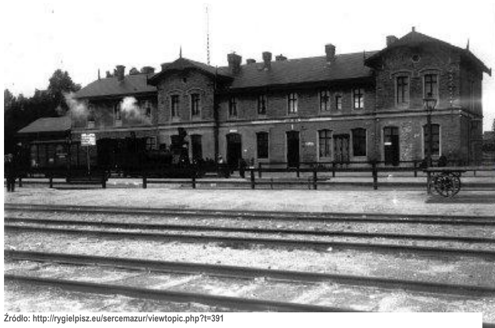
Giżycko, dworzec po rozbudowie, widoczne pokrycie dachowe
