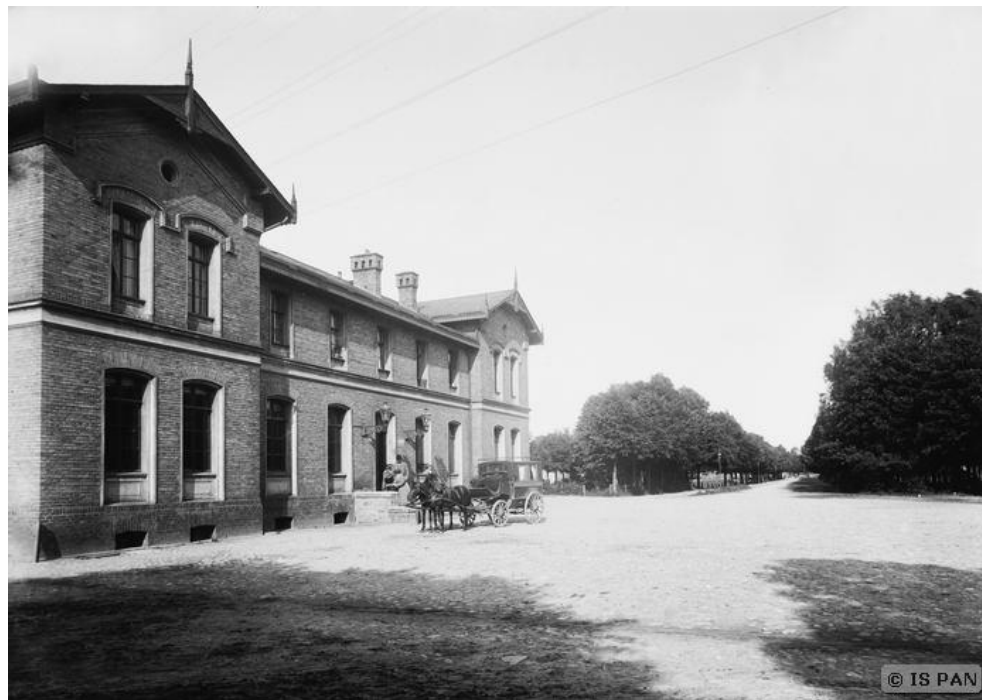
Giżycko, elewacja frontowa dworca wg tego samego projektu. Widoczne detale dachu.
