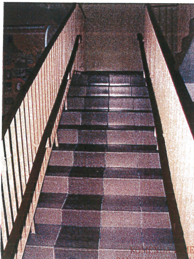
Zdjęcie nr 10 Widok biegu schodowego klatki schodowej KL 1 w poziomie I kondygnacji nadziemnej
