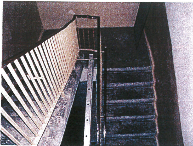
Zdjęcie nr 12 Widok biegów schodowych oraz spocznika pośredniego klatki schodowej KL 2
