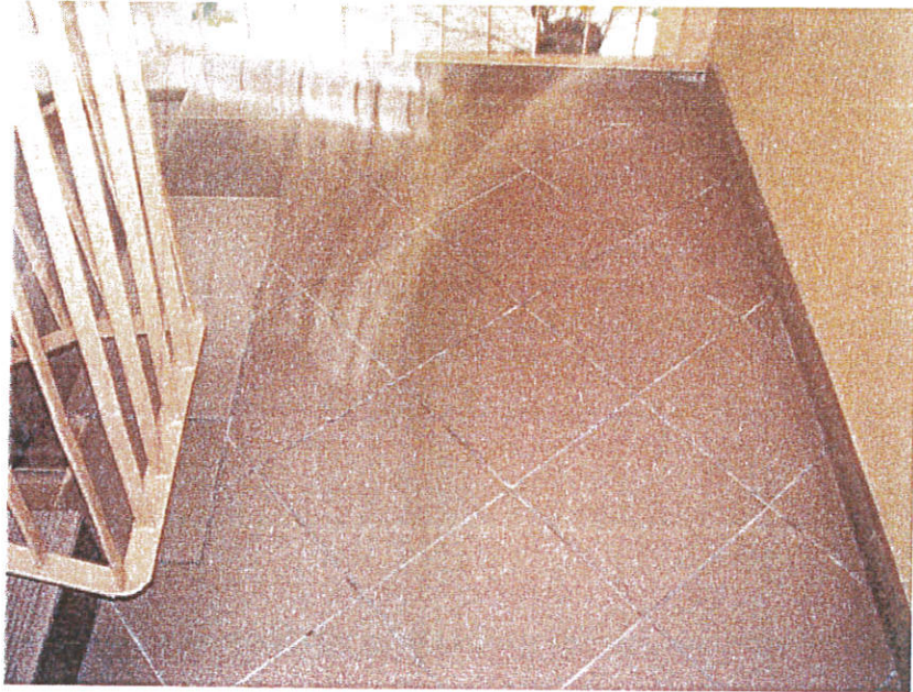
Zdjęcie nr 11 Widok spocznika pośredniego klatki schodowej KL 1
